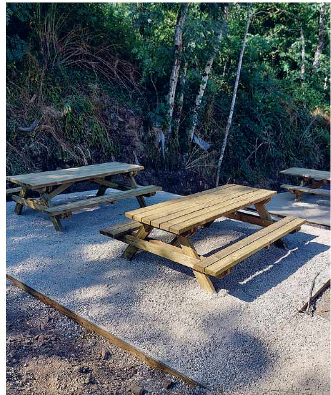
Travaux 2023 - Section Burdignes - Saint-Sauveur-en-Rue
